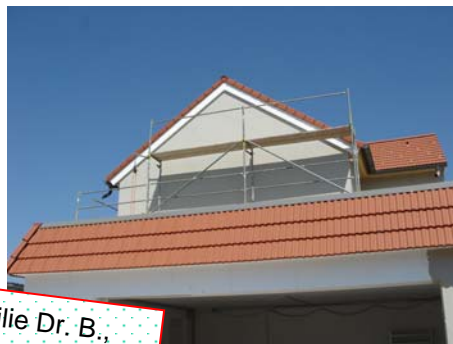
Baubeginn bei Fam. Dr. K., Bad Fischau-Brunn, April 07
